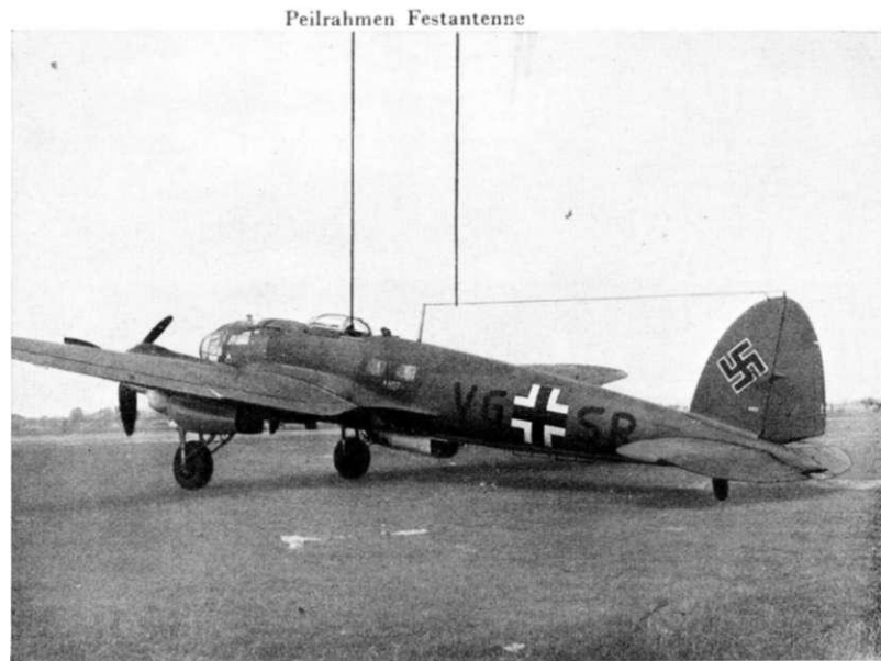
Abb. 21: Festantennen-Anlage und Peilrahmen auf dem Flugzeug
